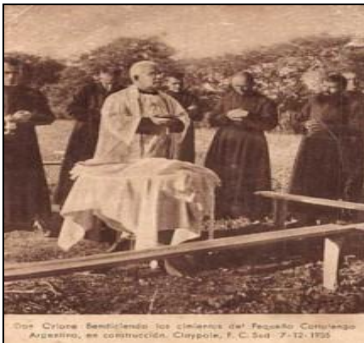
"Don Orione bendiciendo los cimientos del Pequeño Cottolengo Argentino, en construcción. Clappole, F. C. Sed. 7-12-1935"
